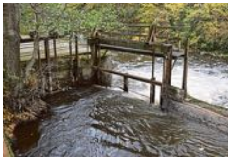
Die Metallkonstruktion des Wehrs soll aufgearbeitet und an anderer Stelle wieder aufgebaut werden. Fotos: Wolfgang Kirfel
