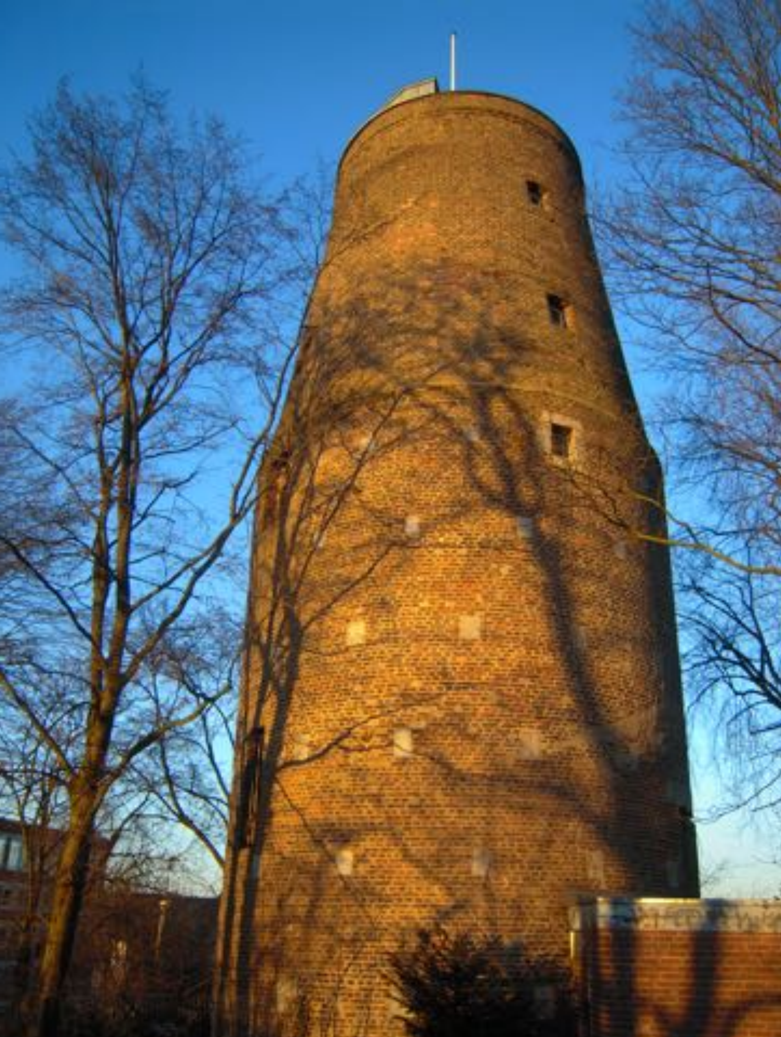
DER TURM DER STADTMÜHLE GELDERN WEIST IM OBEREN DRITTEL EINE KONISCHE VERJÜNGUNG AUF, DIE WAHRSCHEINLICH IM ZUSAMMENHANG MIT DER MODERNISIERUNG, DER DREHbaren HAUBE, ENTSTAND. © ALTEMÜLLER 2016.
